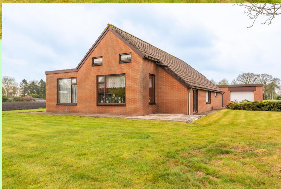
Parallelweg 1 te Bellingwolde
